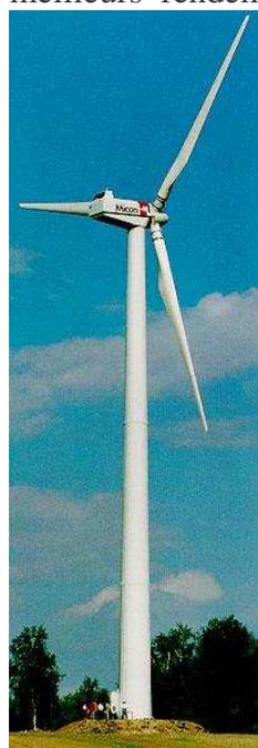
L'éolienne fonctionne parfaitement avec des vents autour de 10 mètres/s. On remarque aussi que l'on ne récupère pas la totalité de l'énergie du vent. On observe aussi de meilleurs rendements avec des vents de 3 à 10 m/s. Mais ces rendements ne sont pas excellents. Il y a des pertes d'énergie dans la conversion mécanique électrique. Quel est le chemin emprunté après avoir été capté par l'éolienne ?
